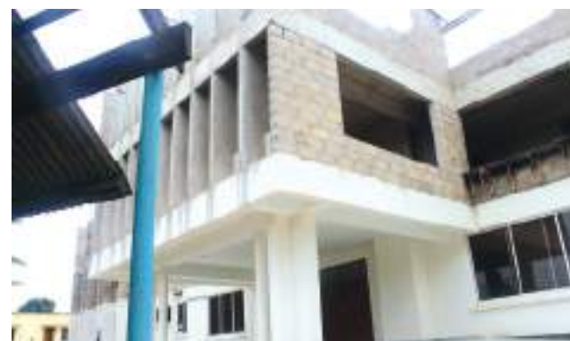
JENGO linaloendelea kujengwa la mama na mtoto.
