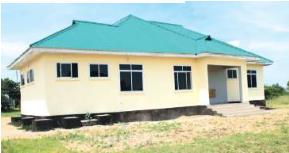
UJENZI wa kituo cha huduma jumuishi (one stop centre).
