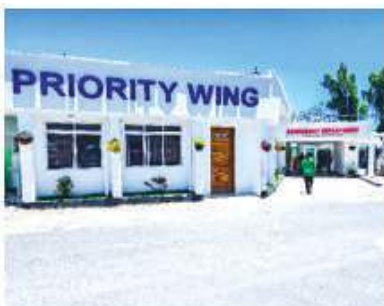
Jengo la kutolea huduma za Binafsi (Private Service)
