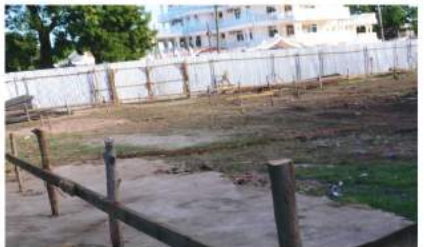
Hatua za Ujenzi wa Kituo cha damu salama
