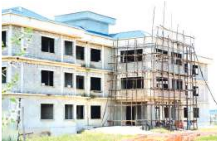
JENGO la mama na mtoto ujenzi wake unaendelea.
