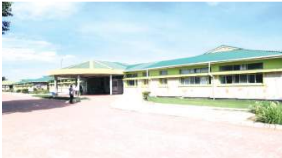
JENGO la Hospitali linalotoa huduma kwa sasa.
