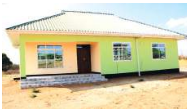
UJENZI wa nyumba ya Mtumishi ambayo imekamilika.
