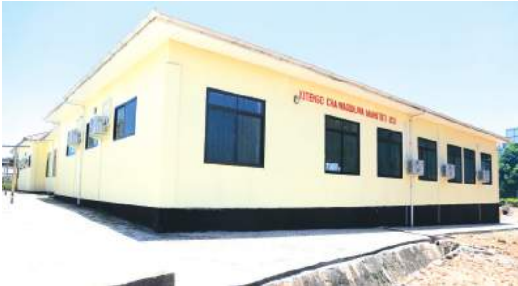
Muonekano wa jengo jipya la Wagonjwa Mahututi (ICU) katika Hospitali ya Rufaa ya Mkoa, Bukoba.
