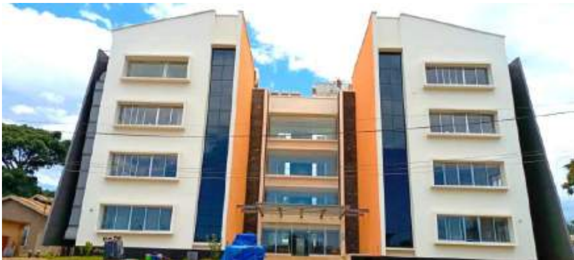
Maabara ya Afya ya Jamii ya Usalama wa Kibailojia Daraja la tatu ngazi ya Kimataifa iliyojengwa katika Hospitali ya Kibong'oto na kugharimu Shs Bilioni 22.5 ikiwa ni ujenzi na vifaa
