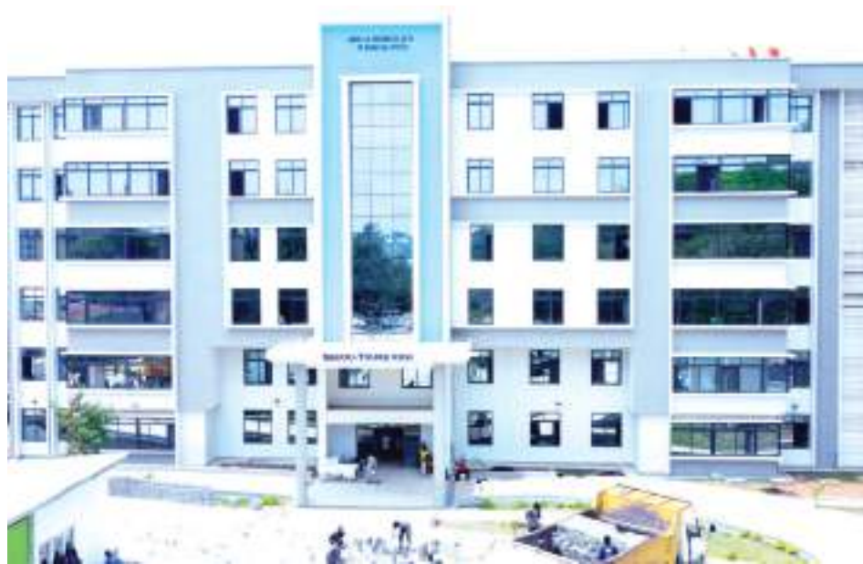
Jengo la huduma ya Afya ya Mama na Mtoto.
