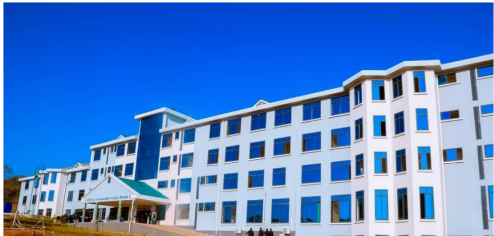
Jengo la Hospitali ya Rufaa ya Kanda ya Kusini Mtwara
