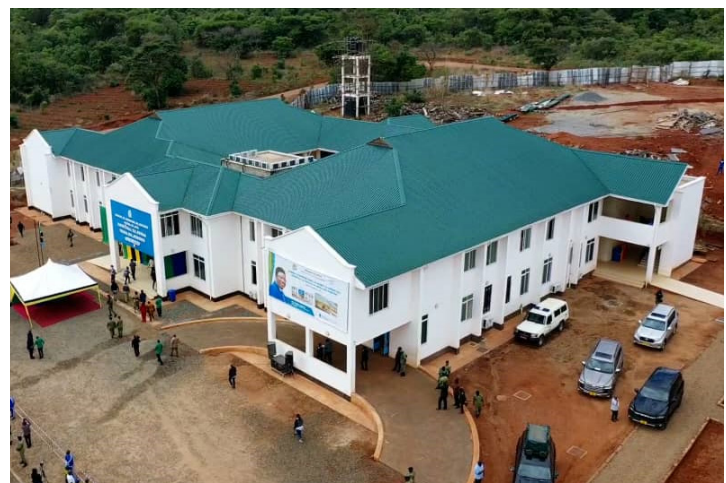
Majengo katika Hospitali ya Rufaa ya Mkoa wa Songwe
